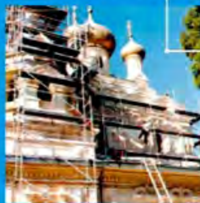
Фасадные леса рамного типа
