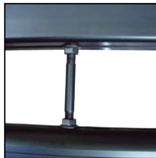
Рис.2 Закрепление под нагрузкой точки подвеса в верхнем профиле
