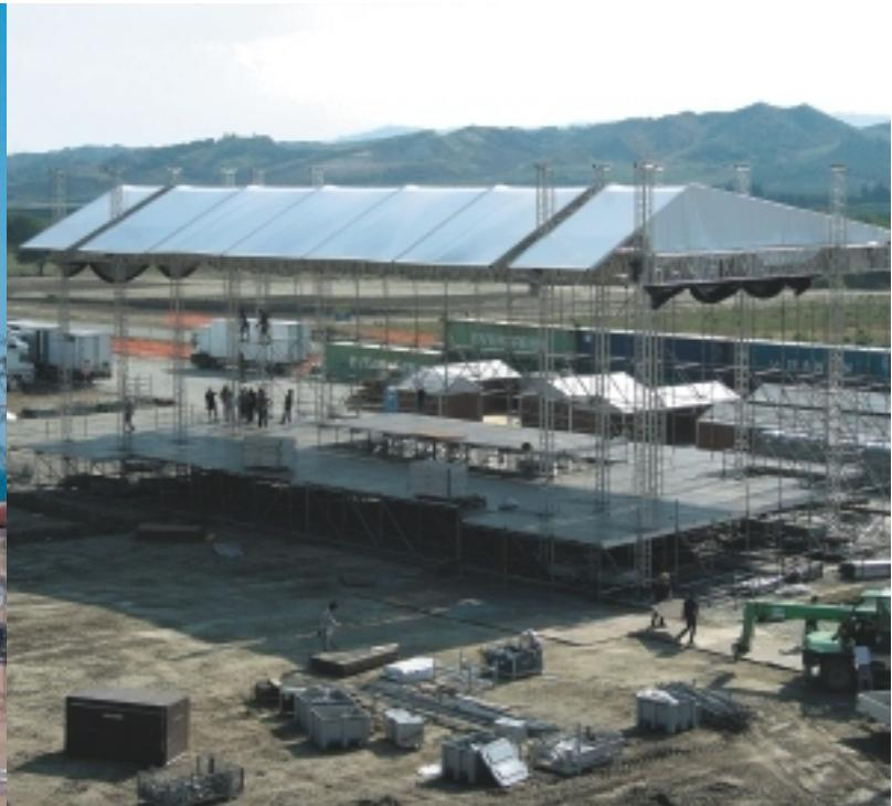
В отличие от крышных систем ST или MPT, крышная система LT может иметь различные скаты. У этой системы имеется стандартный консольный свес в 2 метра в передней части конструкции для защиты от дождя или солнца. В качестве опоры для этой системы используются шесть башен ST — стропильная ферма B100RV, как основная опора, и S100F, как дополнительная. Специальный комбинированный крышный профиль монтируется поверх опор с помощью регулируемых суппортов.
