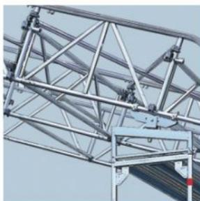
Опорный элемент с 3 осями вращения и 4 степенями свободы позволяет устанавливать односкатные и двускатные крыши, и компенсировать допуски несущей конструкции.
