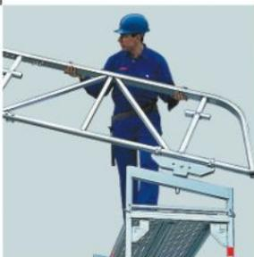
Заранее собранные фермы устанавливаются на балочные опоры, выравниваются по вертикали и фиксируются. Затем устанавливается следующая ферма. Между собой фермы крепятся растяжками.
