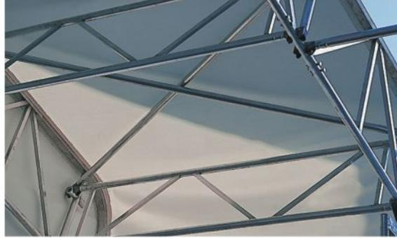
Ветровые раскосы требуются только для каждого пятого пролета – **Алюминиевые** компоненты позволяют снизить вес конструкции и сократить время сборки. Для получения надежного соединения достаточно лишь вставить элемент с держателем. (Допустимые пролеты – до 15,6 м, как показано на иллюстрации.)
