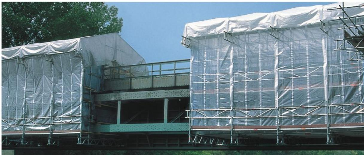
Для создания боковых и крышных конструкций могут использоваться самые разные покрытия – например: тенты, панели, модульные элементы Защитной Системы с прозрачными кассетами, пропускающими дневной свет, запирающиеся двери и многое, многое другое, на выбор с учетом длины пролетов.
