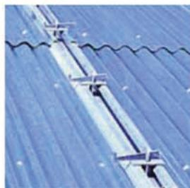
Кассеты крыши фиксируются клиньями, что предотвращает их отрыв от опоры. Они повышают жесткость ферм и обеспечивают ровную поверхность крыши, выдерживающие большие нагрузки.
