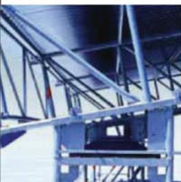
Поддерживающие балки передают нагрузку крыши на опорную конструкцию и позволяют компенсировать разницу в ширине.
