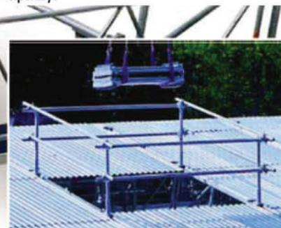
Внос строительных материалов через крышу: в любом месте кассетной крыши можно вынуть часть элементов для того, чтобы доставить материалы точно в нужное место.
