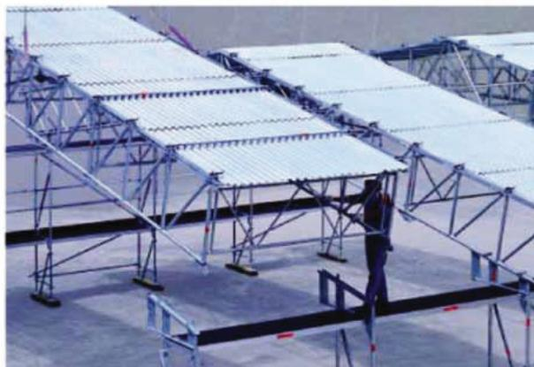
Сборка и установка усилителей на балочные перекладины производится на земле. Затем на них помещаются кассеты крыши. Готовые элементы поднимаются краном на опорную конструкцию. Такая готовая ферма требуется только для каждого второго пролета. Это экономит материалы и сокращает время сборки.
