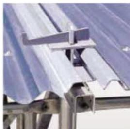
Верхний обвязочный пояс балочной перекладины крепит кассеты крыши, а также служит для соединения перекладин и в качестве дренажного элемента.
