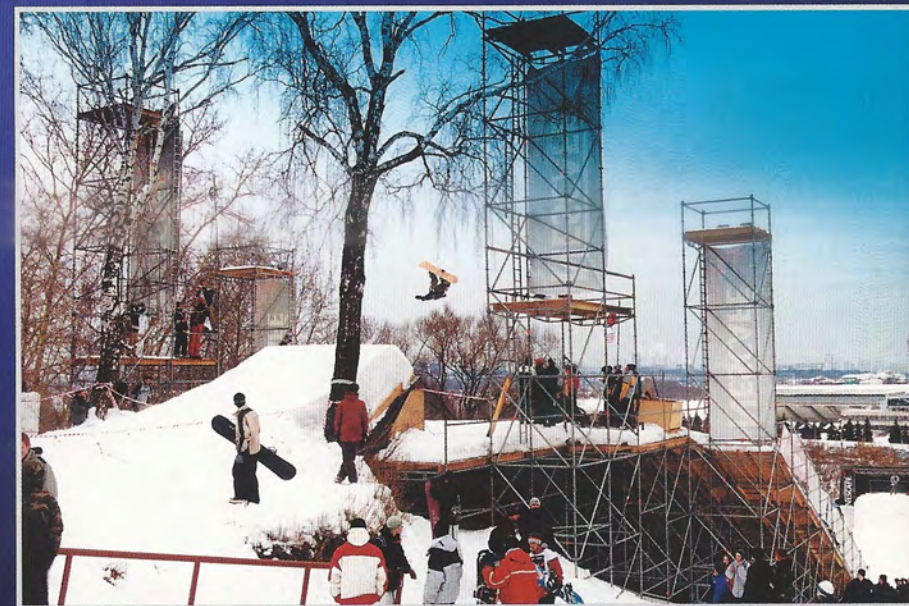
Конструкция трамплина для сноуборда. Фестиваль "Чистая энергия" в Крылатском.
