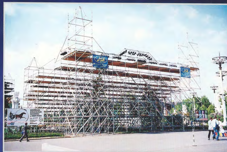
Конструкция трибуны на 1000 человек для съемок к/ф "Небо в алмазах".
