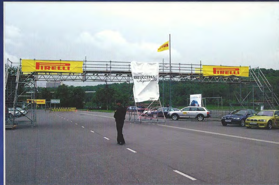
Конструкция пешеходного моста. Рекламная акция Pirelli в Лужниках.
